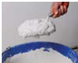
slutpuds i den rigtige konsistens
