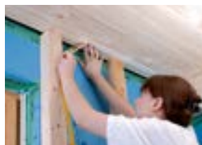
Tætningsbånd/mellemlægspapir påsættes
