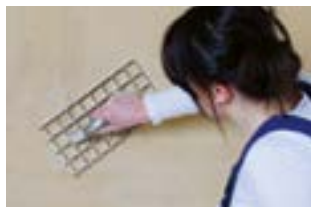
overfladen glattes med nivejern
