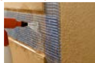
De forsænkede sider fugtes
