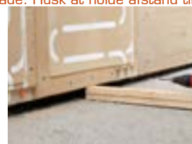
Afstandsholder ved gulvet
