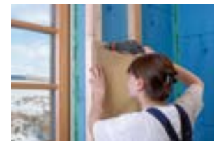
monter den tilstødende plade
