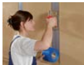
Armeringsvævet hæftes fast på de forsænkede sider
