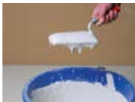
den rigtige konsistens til basislaget
