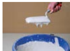
den rigtige konsistens til basislaget
