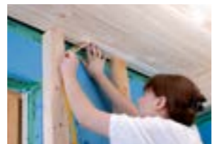
Tætningsbånd/mellemlægspapir påsættes
