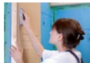
etablering af spartelkant
