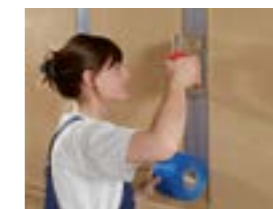
Armeringsvævet hægtes fast på de forsænkede sider
