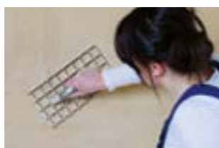
overfladen glattes med rivejern
