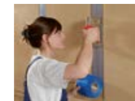
Armeringsvævet hægtes fast på de forsænkede sider
