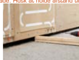
Afstandsholder ved gulvet
